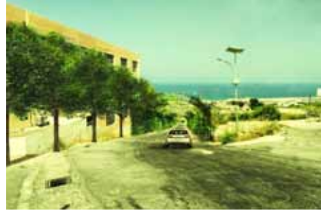
صورة مأخوذة لمدخل البلدة، لجهة الشمال قرب مقام سيده المنطرة في مغدوشة بعد التدخل بها
